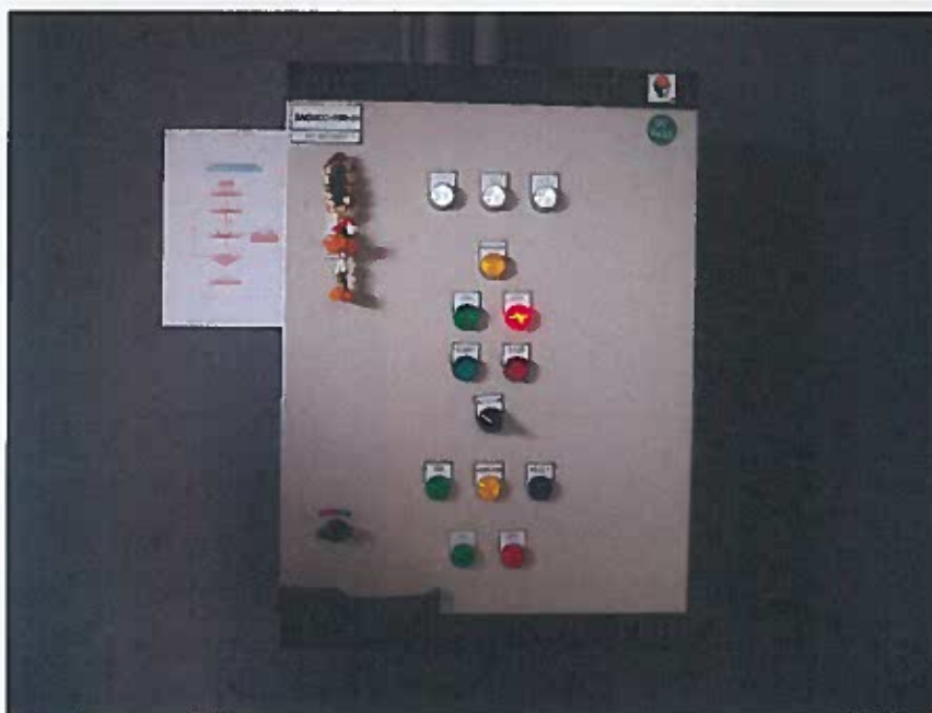
ภาพระบบพัดลมอัดอากาศและอุปกรณ์ประกอบ มีการตรวจสอบและดูแลจากช่างอาคาร
