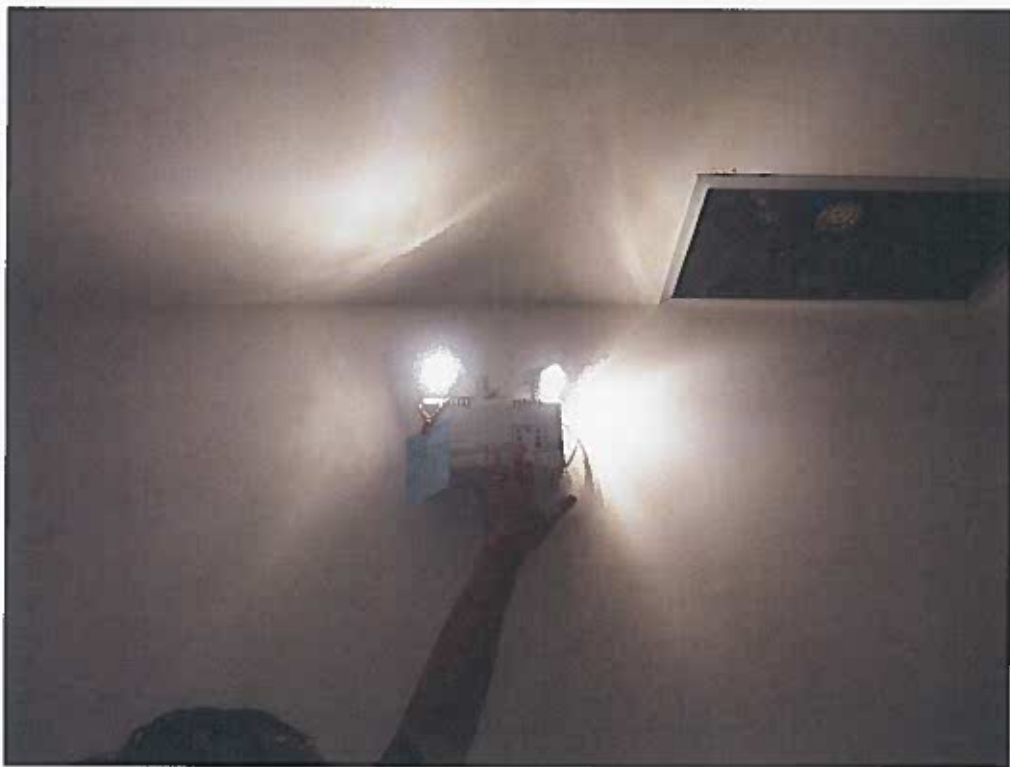
ภาพการทดสอบไฟส่องสว่างฉุกเฉิน
